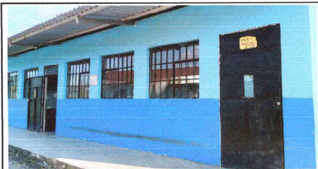
Foto 3: Mantenimiento a puertas de metal
