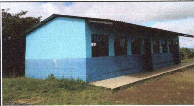
Foto1: Sustitución de pintura
