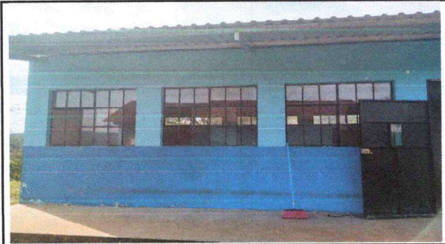
Foto 2: Aplicación de pintura a dos manos.
